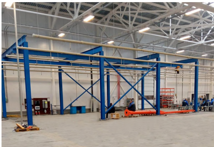
Монорельсовая эстакада длиной 17,0 метров и шириной 8,0 метров для талей электрических передвижных грузоподъемностью 2,0 тонны для предприятия в Белгородской области.
