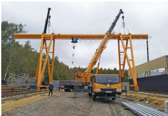
Кран козловой однобалочный с электроприводом грузоподъемностью 10,0 тонн и длиной пролета 16,0 метров для предприятия в Московской области.
